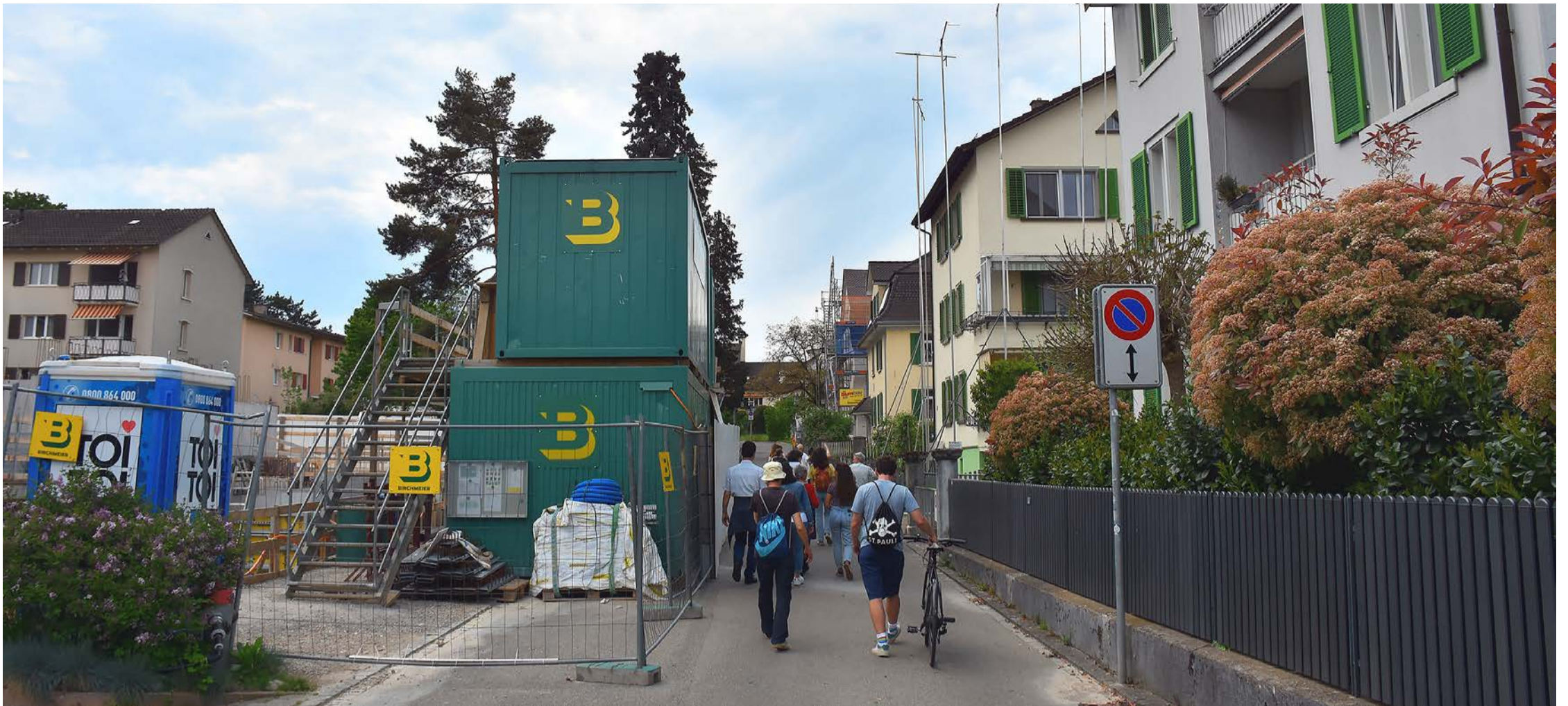
Der sogenannte «Jane's Walk» – benannt nach der verstorbenen Journalistin Jane Jacobs – führte auch an Baustellen und Baugespannen vorbei. Letztere sind Vorboten für bauliche und soziale Veränderungen.
